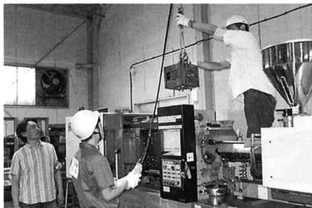
金型の取付作業
