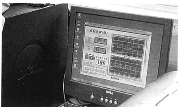
デマンドコントロール監視画面
