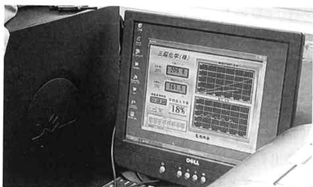
デマンドコントロール監視画面
